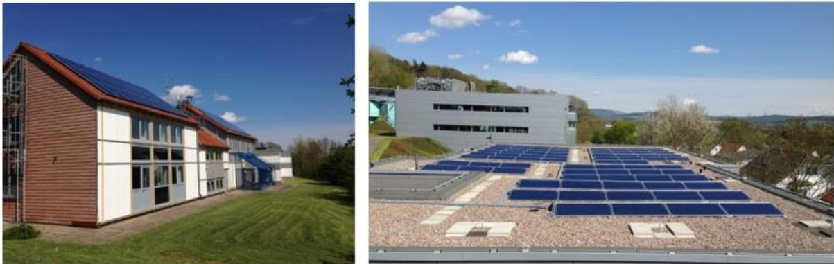
**Abbildung 11: Photovoltaik-Anlagen auf dem Gelände des ISFH. Links: Anlage mit Süd-Ausrichtung. Rechts: Anlage mit Ost-West-Ausrichtung auf einem Flachdach.**
