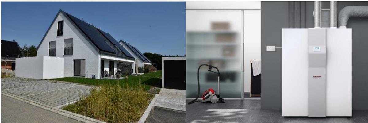
**Abbildung 19: Gebaude der Effizienzhaus-Plus-Siedlung Hugelshart (links) und das verbaute Luftungsintegralgerat LWZ 504 von Stiebel Eltron (rechts) zur Warmwasserbereitung, Heizung, Kuhlung und Gebaudebeluftung**
