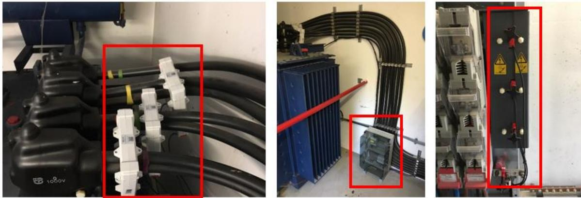
Abbildung 7: Messtechnik am Ortsnetztransformator. Links: Stromwandler an Niederspannungsseite des ONT. Mitte: Messbox mit Gateway. Rechts: Spannungsabgriff im Ortsnetz.
