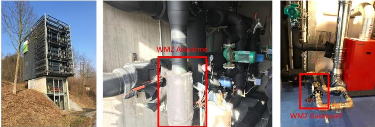
**Abbildung 8: Wärmezentrale des kalten Nahwärmenetzes. Links: Technikurm. Mittel: Hydraulische Weiche mit WMZ für Abwärme. Rechts: Gaskessel mit WMZ.**
