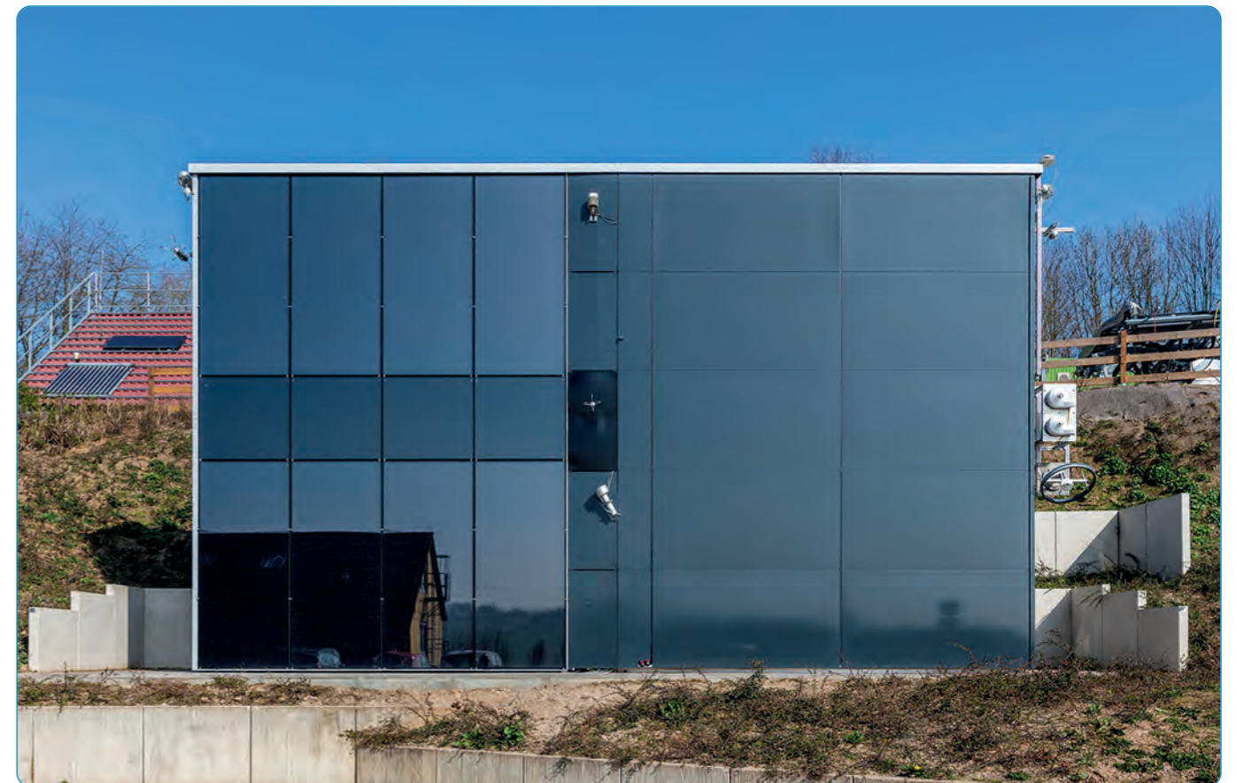
Abbildung/Figure 46: ISFH-Fassadenteststand. Links: solarthermisch-aktive Isolierglas-Fassade (aktivierte Fassadenfläche 22 m 2 ). Rechts: solarthermisch-aktive Metall-Fassade (aktivierte Fassadenfläche 26 m 2 )
