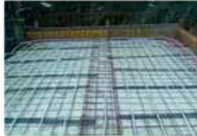
Durch Kunststoff- oder Kupferrohre werden massive Betonsteile aktiviert, sodass sie Wärme speichern und verteilen können.
