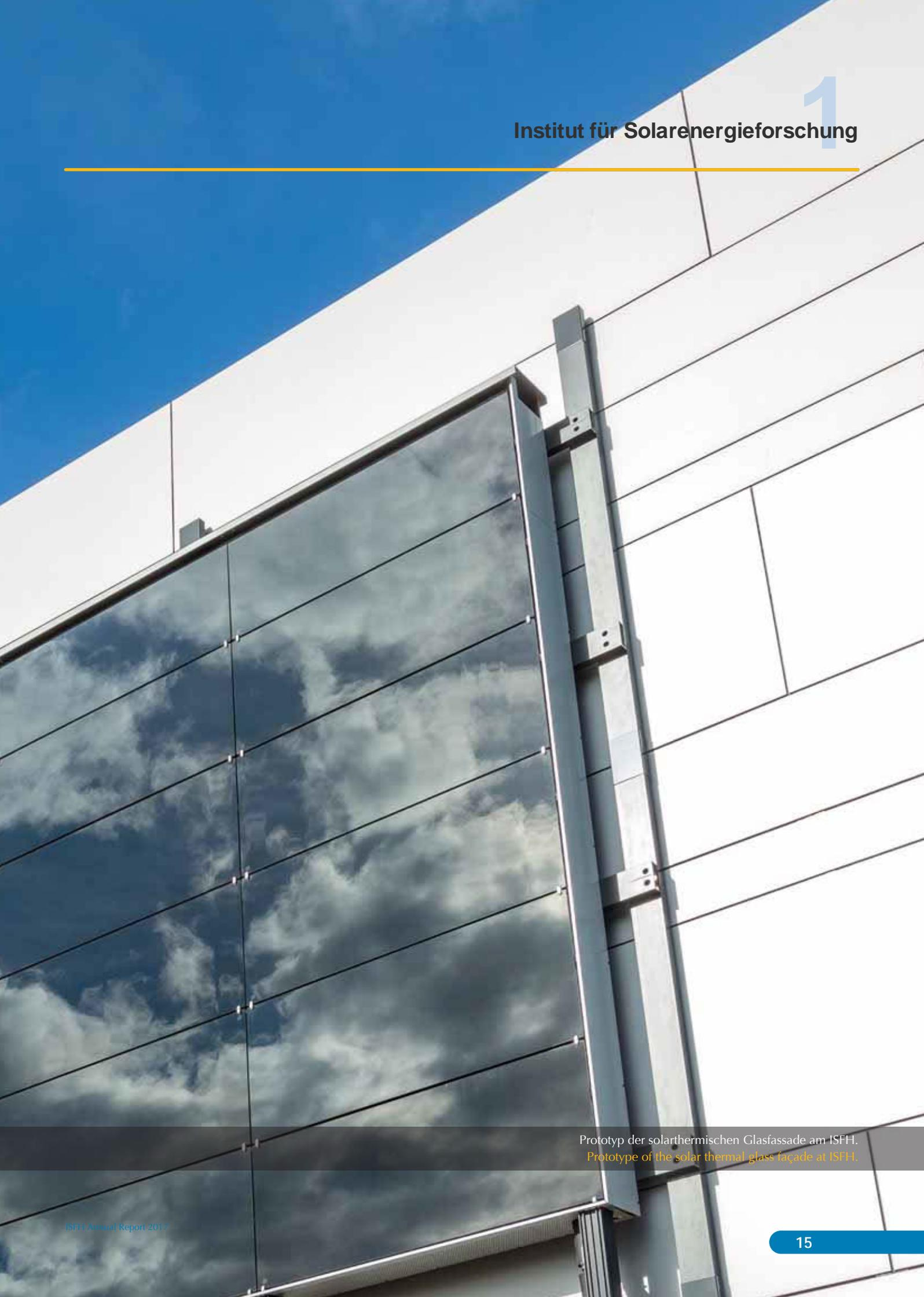
Prototyp der solarthermischen Glasfassade am ISFH.
