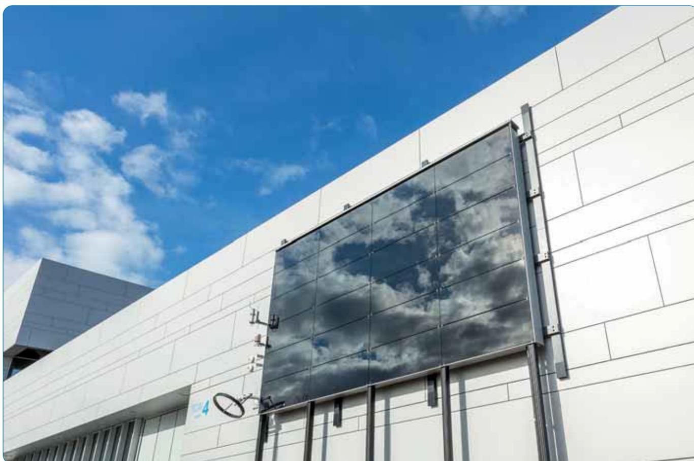
Abbildung/Figure 62: Großformatiger (20m<sup>2</sup>) Prototyp einer solarthermischen Glasfassade am ISFH zur Durchführung der Untersuchungen zur Leistung und Gebrauchstauglichkeit. Die Installation besteht aus 18 aktivierten und sechs nicht aktivierten schwarzen Glasmodulen.
