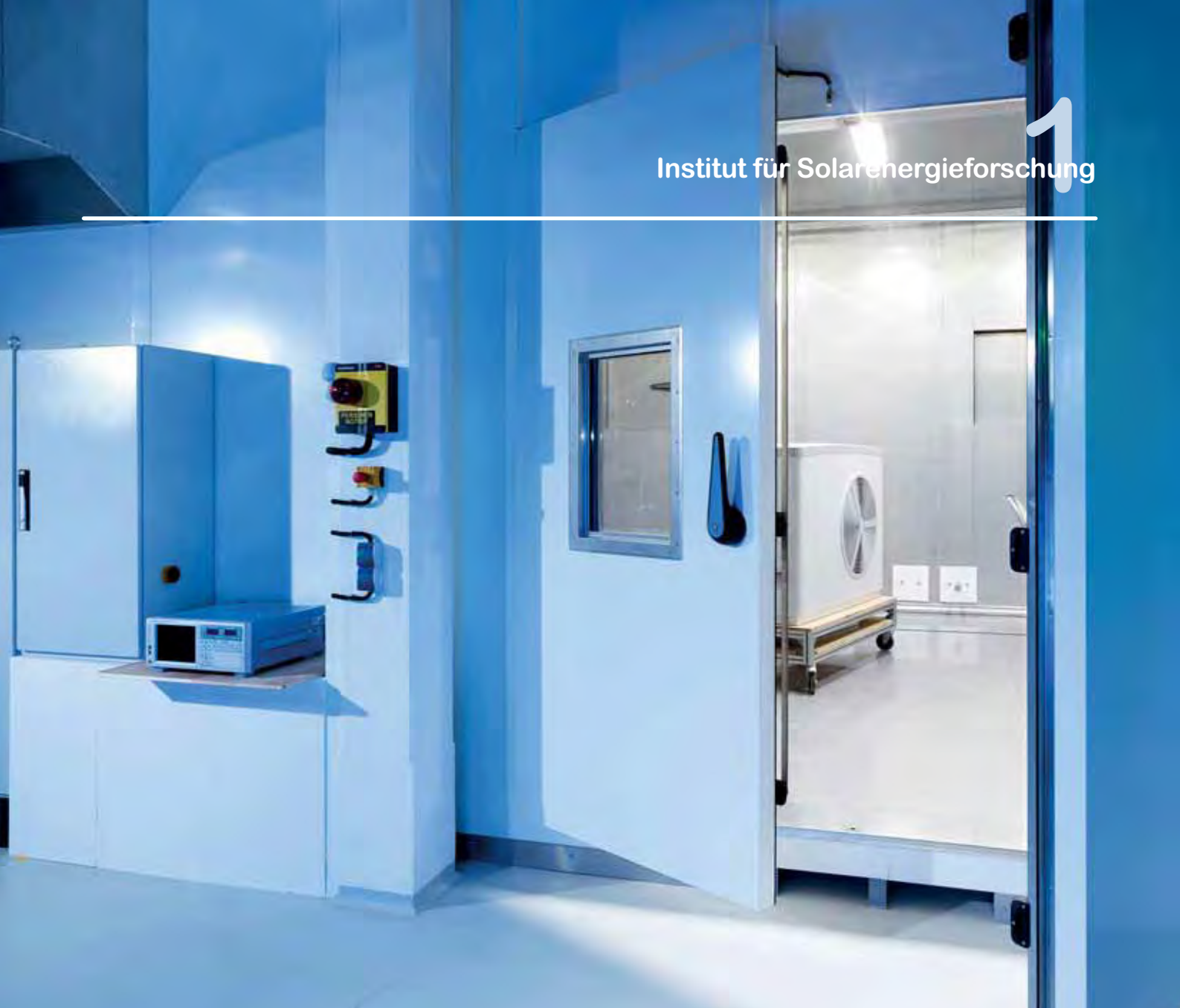
Einblick in die Klimakammer des Wärmepumpenprüfstandes. View into the climate chamber of the heat pump testing stand.
