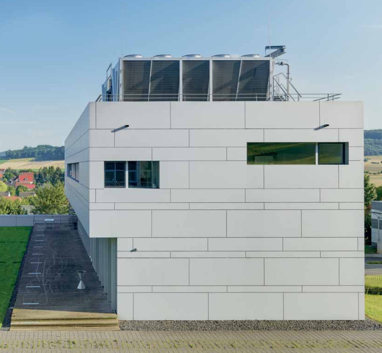
Der Bürotrakt auf dem Dach des ISFH-SolarTeC Gebäudes. The office wing on top of the ISFH-SolarTeC building.
