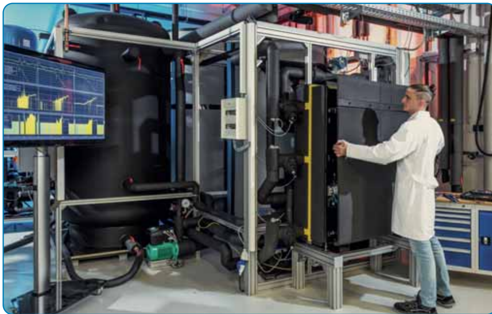
Einrichtung einer Frischwasserstation zur Untersuchung am Prüfstand für Wärmeübergabestationen. Installation of a domestic hot water module for testing on the test bench for heat transfer stations.
