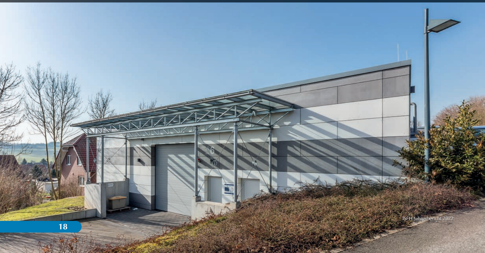
Laborgebäude für Integrierte Solare Systemtechnik (ISS). Integrated Solar Systems Technology (ISS) laboratory building.
