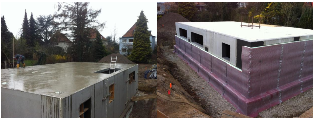
Abbildung 4.16: Kellerdecke betoniert & Keller fertig inkl. Dämmung und Anfüllschutz
