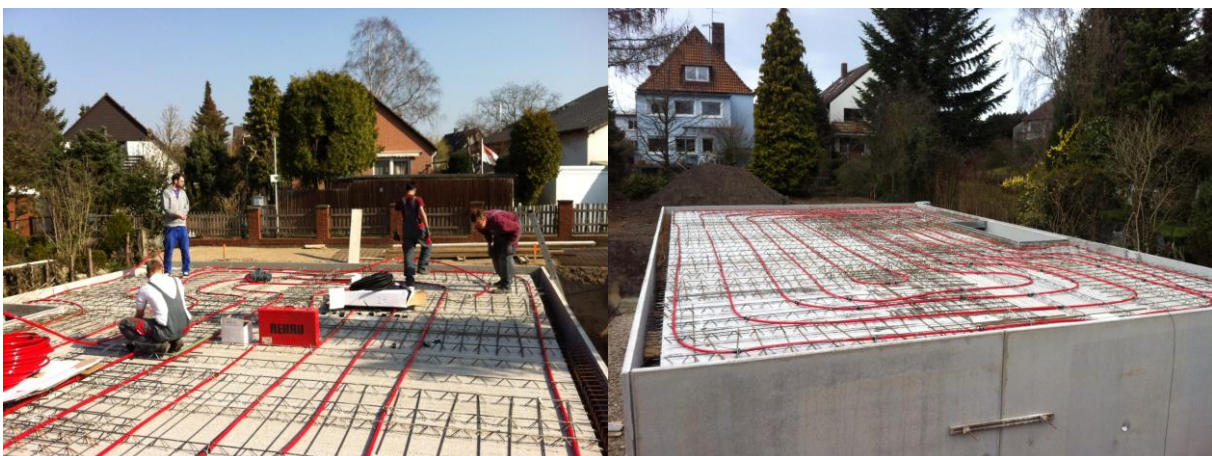
Abbildung 4.17: Verlegen der BTA auf KG-Decke
