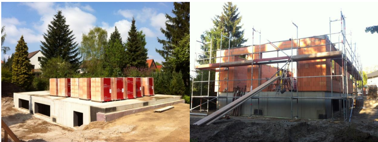
Abbildung 4.19: Beginn und Abschluss EG-Mauerwerk
