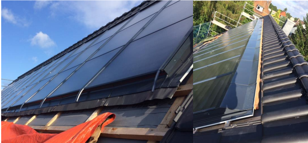
Abbildung 4.22: Montage der Solaranlage abgeschlossen
