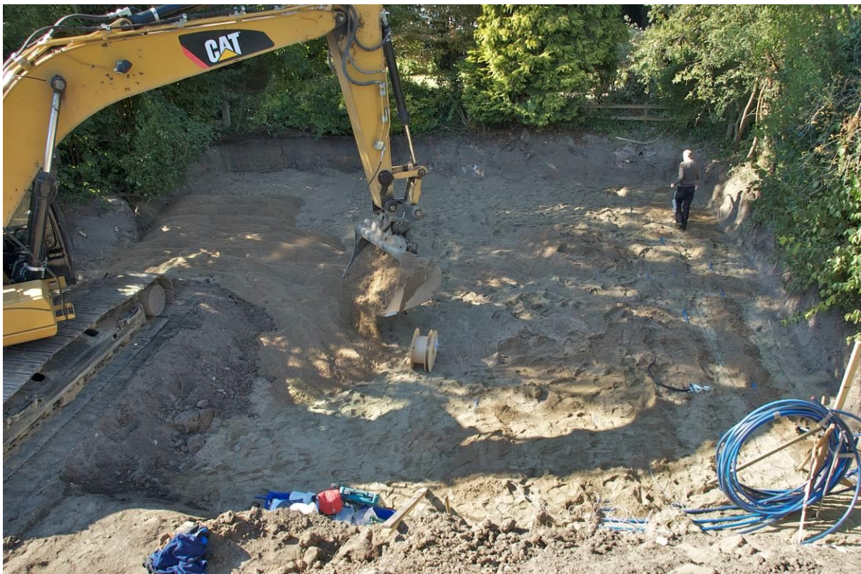
Abbildung 4.1: Einbau des Erdwärmekollektors, das Foto zeigt die bereits fertig gelegten Leitungen mit einer Überdeckung aus Füllsand.
