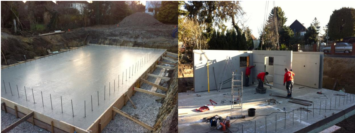
Abbildung 4.15: Bodenplatte betoniert & Stellung Kellerwände
