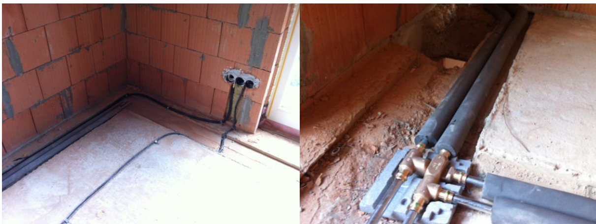
Abbildung 4.21: Verlegung der Heizungsleitungen im OG inkl. Knotenpunkte
