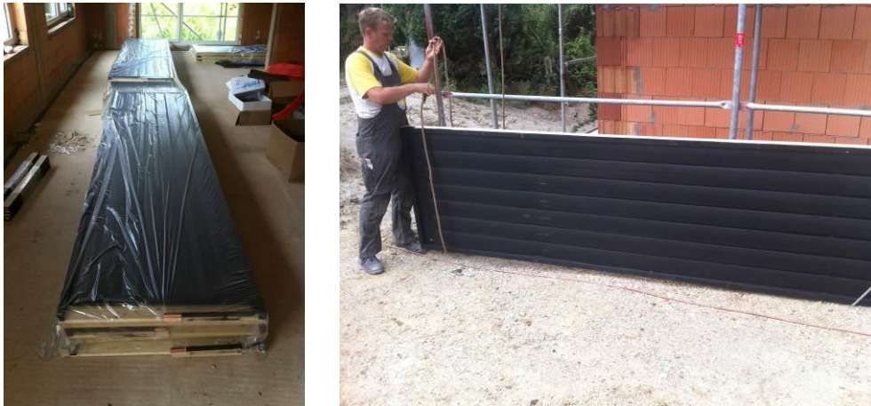
Abbildung 4.2: Absorbermodule ohne Rahmen und Abdeckung während der Installation
