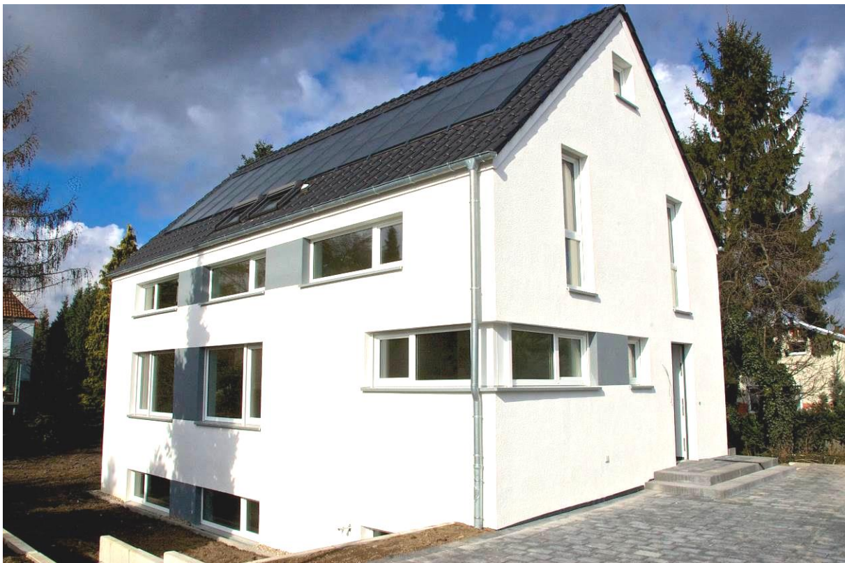
Abbildung 4.3: Fertiggestelltes Kollektorfeld mit vollständiger Dacheindeckung
